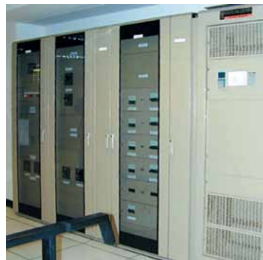
Распределительные щиты низкого напряжения Prisma P
